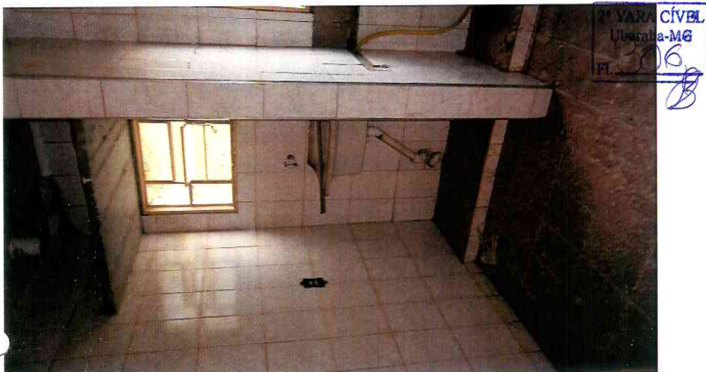
ÁREA DE SERVIÇO. (OBS. PAREDE RETIRADA ENTRE ÁREA DE SERVIÇO E COZINHA).
