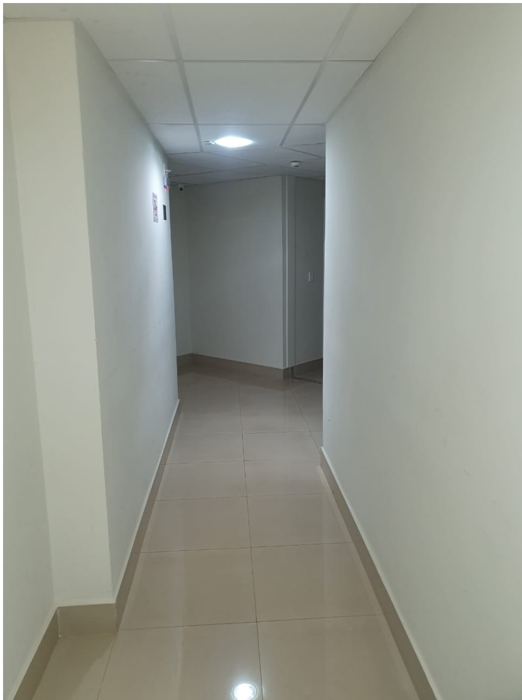
Parte interna do prédio em ótimo estado.
